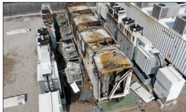
Slika 5: Šteta od eksplozije BESS u Liverpoolu (Izvor: BBC)
