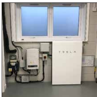
Slika 1: Stambeni BESS (izvor: Empower Energy)
